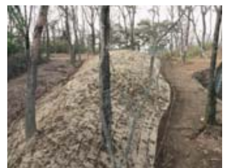
西城筋違い南土塁整備状況
